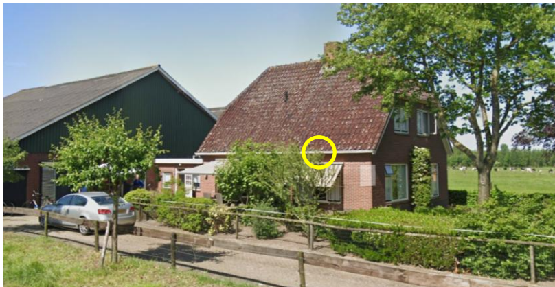
Aanduiding van de nestplaats van huismussen onder de dakpannen van de te behouden woning.
