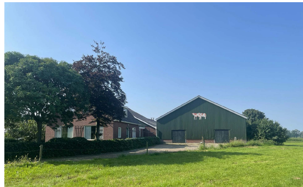
Afbeelding 18. Melkveestal via de voorzijde te betreden. Zicht vanaf de Hessenweg.
