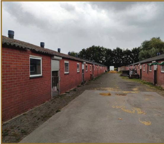
Afbeelding 1.1: Zicht op het plangebied vanaf het zuidwesten; zicht op de noordelijke en middelste schuren.
