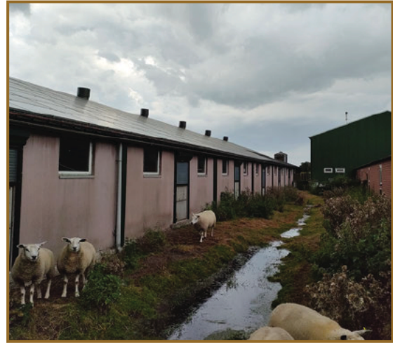
Afbeelding 1.2: Zicht op de oostelijke schuur vanaf het noorden. De strook tussen oostelijke en middelste schuur wordt gebruikt als schapenweide.
