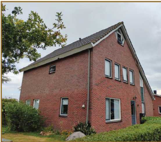
Afbeelding 1.5: Zicht op de te behouden woning vanaf het zuiden.
