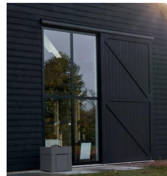
schuurdeur in combinatie met glasgevel
