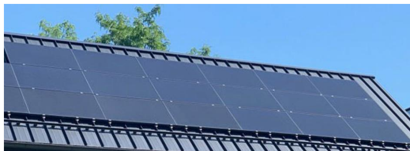
referentie metalendak met zonnepanelen
