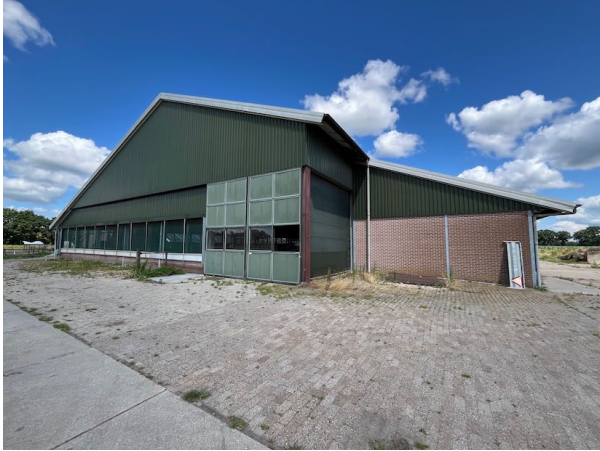
Figuur 2. Westgevel stal.
