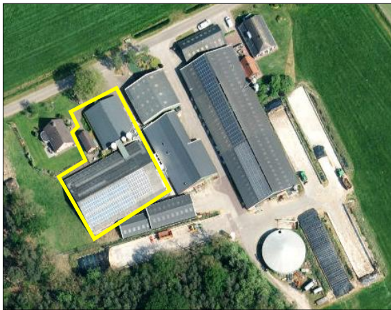
Luchtfoto: varkensstallen en garage weergegeven met geel kader.
