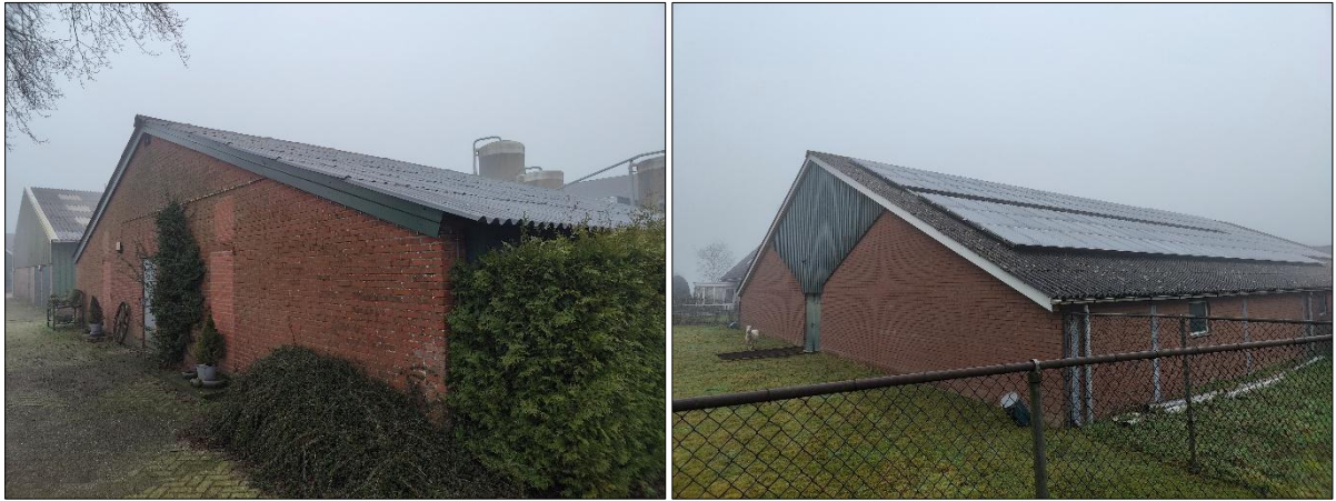
Foto's: vleermuizen kunnen tussen dak overstek en gevel kruipen.
