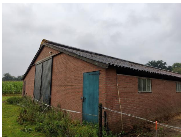
Gebouw met bakstenen buitengevels en luchtpouw.
