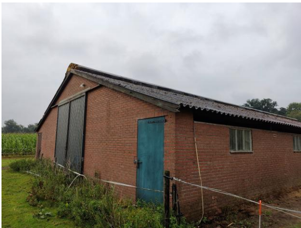
Gebouw met bakstenen buitengevels en luchtspouw.
