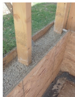
Kalkhennepgevel en rammed earth in de maak
