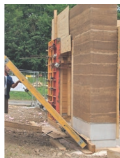
Kalkhennepgevel en rammed earth in de maak
