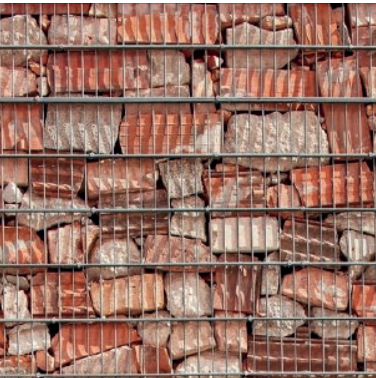
Schanskorf-elementen gevuld met baksteen reststroom
