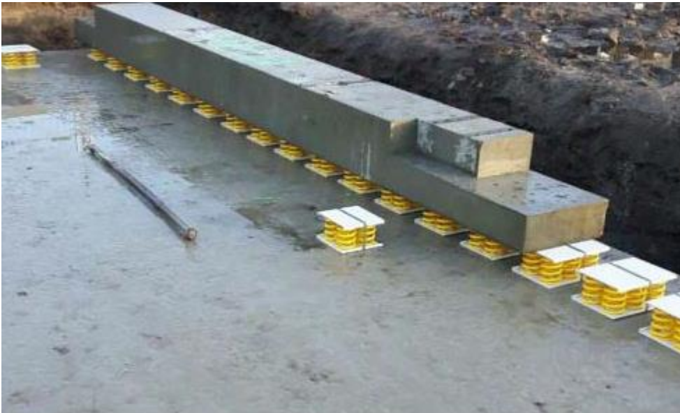
Figuur 26 Dubbele fundering met stalen veerdozen (project in Prinsenbeek)
