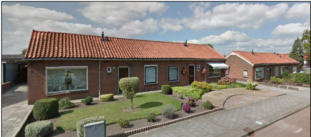
Bestaande bebouwing binnen het plangebied langs de westzijde van de Irenelaan (bron: Google Maps).
