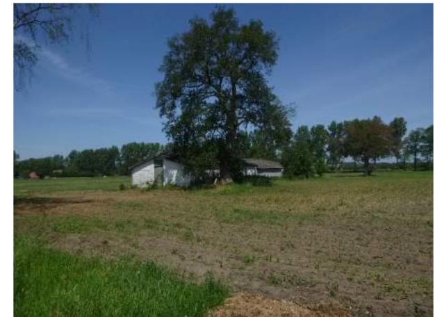
Schuur Groteboersdijk met asbestverontreiniging
