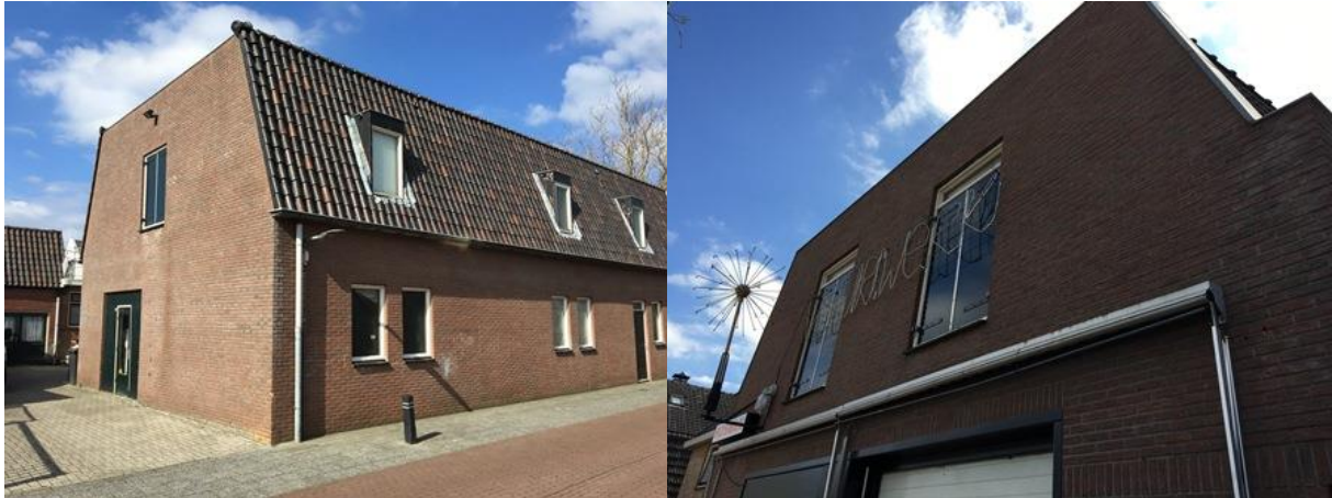
Detailopnames van het onderzochte gebouw.
