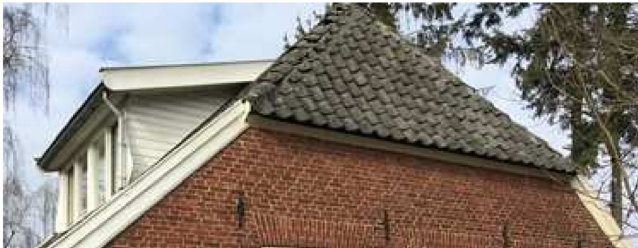
Detailopname van het pannendak van de woonboerderij. Huismussen kunnen eenvoudig onder de dakpannen kruipen om te nestelen.
