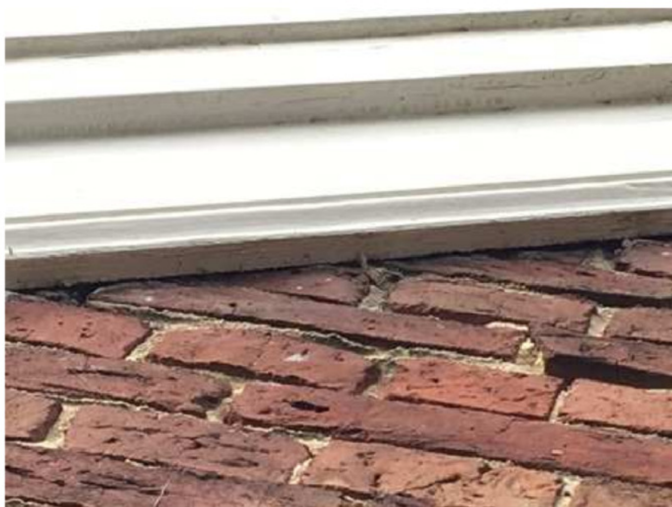
Door windveren strak op de buitengevel te bevestigen kunnen vleermuizen er geen verblijfplaats achter bezetten.
