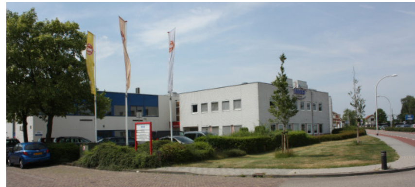
Huidige situatie met het gebouw van de Enkco
