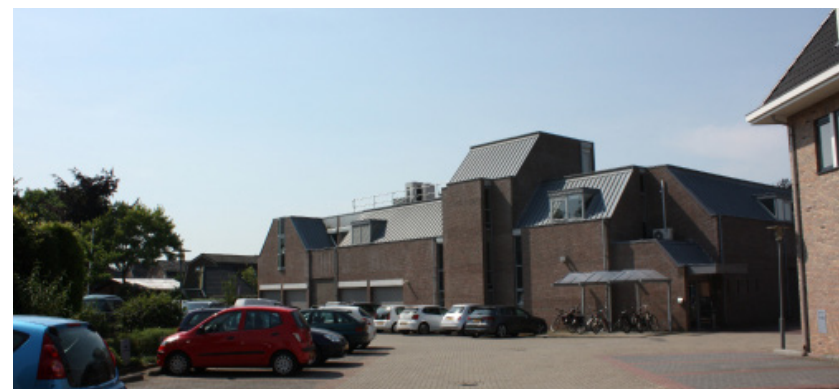
Huidige situatie, achterzijde van de Rabobank met parkeerterrein
