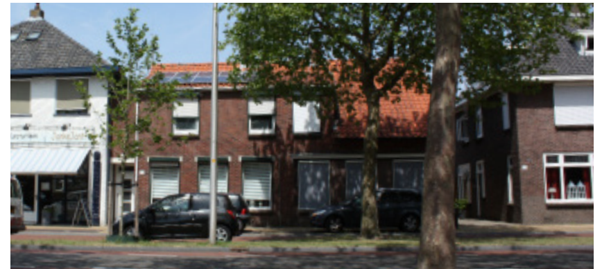
Huidige woning naast het winkelpand
