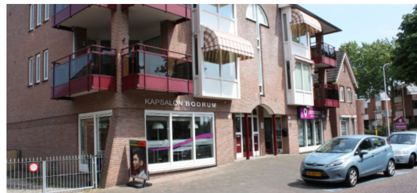
Huidige situatie Enterstraat met beeldverstorende elementen zoals dit gebouw
