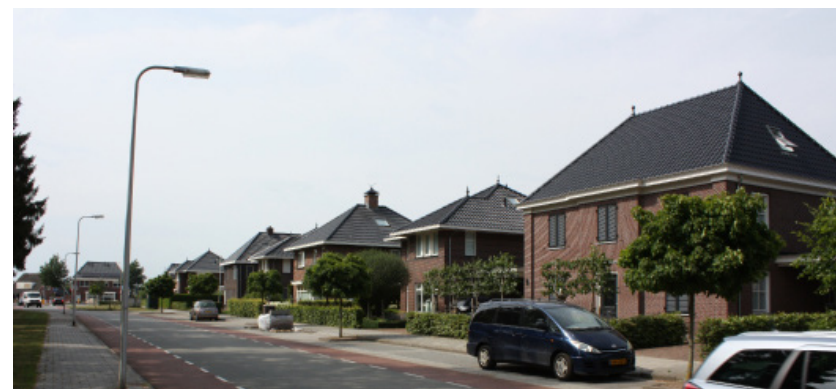
Naastgelegen bebouwing aan de Pelmolenweg
