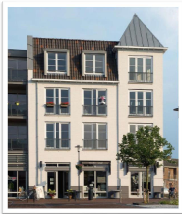
Referentiebeeld van bebouwing waarbij diversiteit in bouwhoogte de individualiteit van het gebouw versterkt
