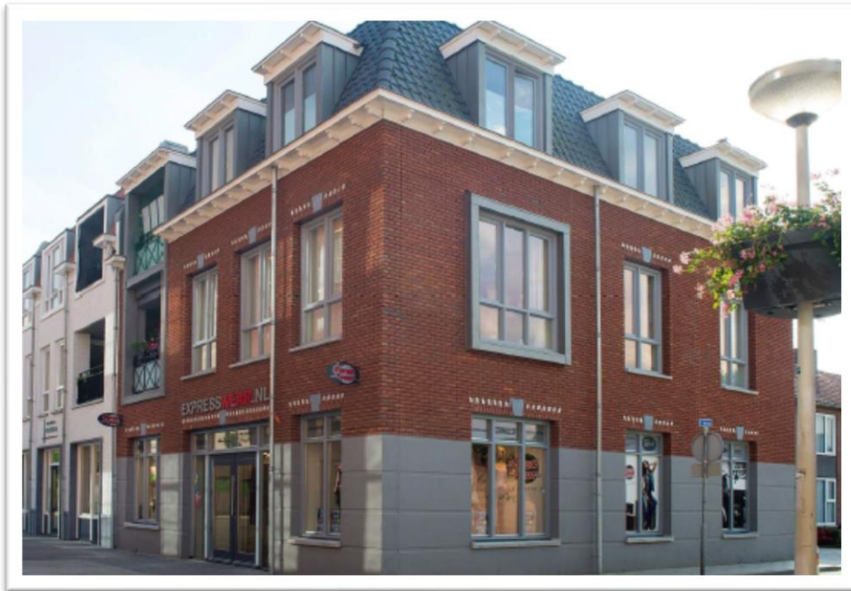
Referentiebeeld waarbij de kopgevel als voorgevel ontworpen is
