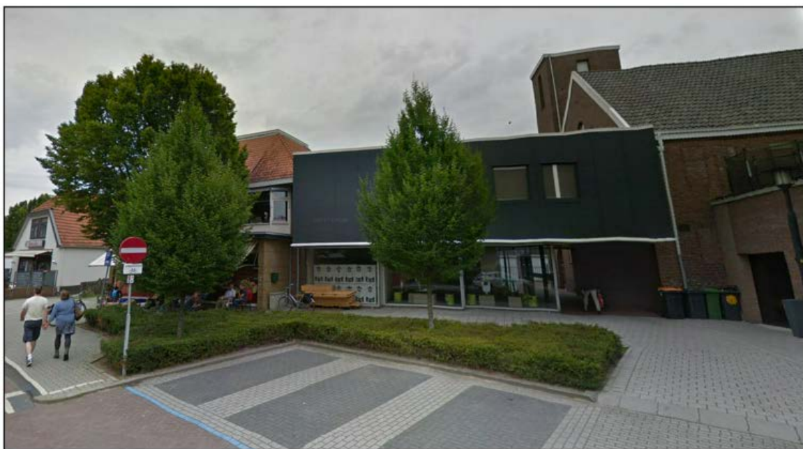
Figuur 2.3 Straatbeeld plangebied (Bron: Google Streetview)
