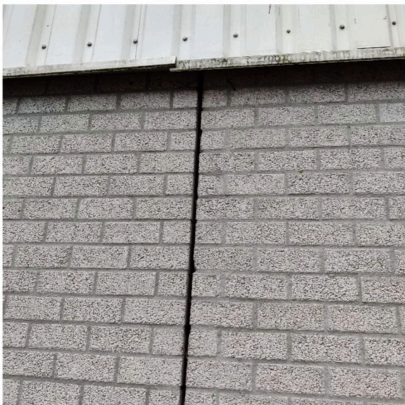
Afbeelding 3: Dilatatievoeg in het stenen gedeelte van het bedrijfspand aan de Morsweg 8.
