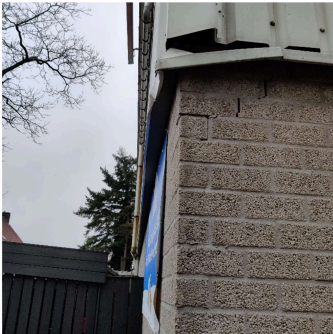
Afbeelding 4: Opening in het dubbelzijdige plaatwerk van het bedrijfspand aan de Morsweg 8.
