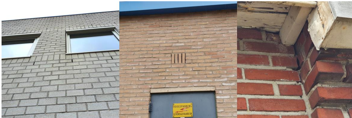
Figuur 3.1 Verschillende typen openingen in gebouwen binnen het plangebied zijn geschikt als verblijfplaats van vleermuizen. Bron foto's: Ecogroen.
