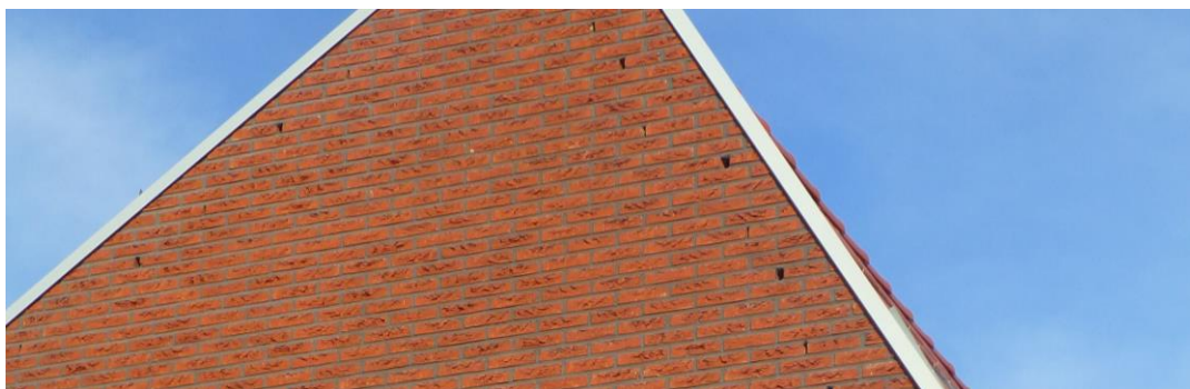
Figuur 4.1 Het realiseren van gebouwen met een toegankelijke spouw via open stootvoegen is voor gebouwbewonende vleermuizen vaak de beste optie. Bron: Ecogroen.
