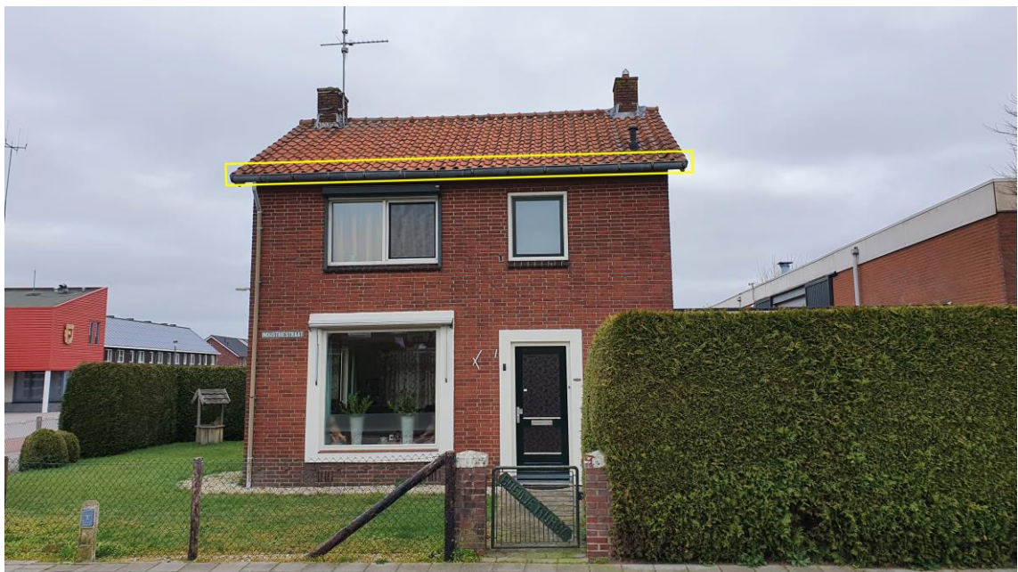
Figuur 3.5 Nestlocatie van zes paar huismussen binnen het plangebied (geel omlijnd) bij Industriestraat 36. Drie andere nesten bevinden zich hier aan de andere kant van het dak. Bron foto: Ecogroen.
