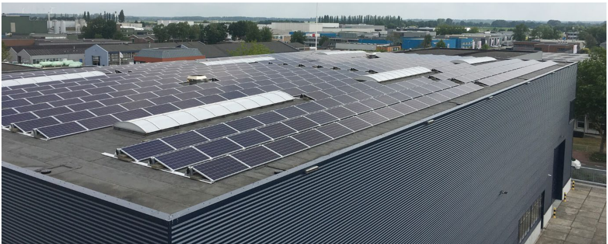
Figuur 21: Referentie toepassen zonnepanelen op nieuw dak bedrijfshal.
