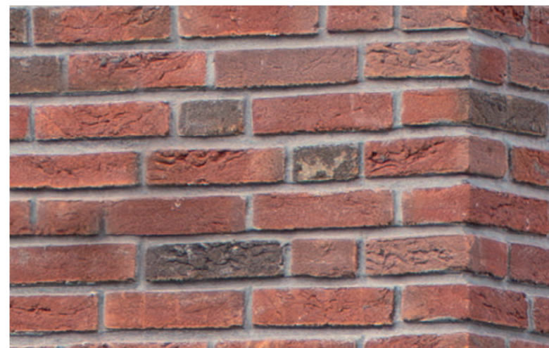
Metselwerk in gedekte kleuren
