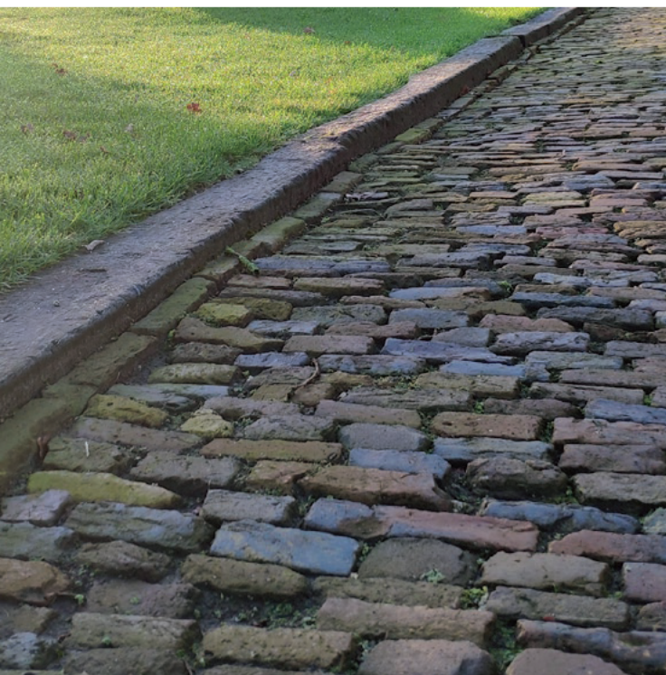
Passende beeldkwaliteit op het erf: klinkers, kantopsluiting en overgang naar (extensief) gazon.
