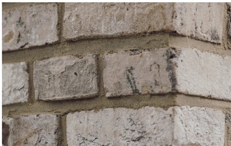
Metselwerk in gedekte kleuren
