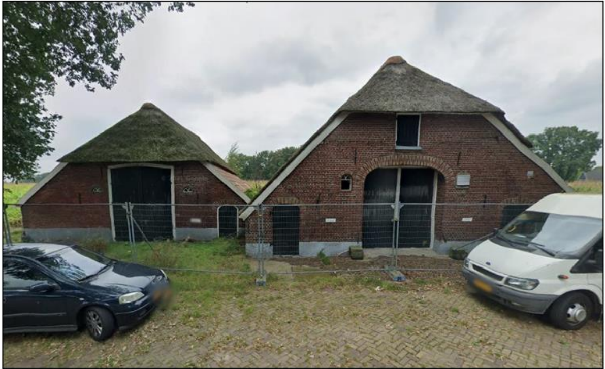
Afbeelding 2.2 Straatbeeldfoto karakteristieke woonboerderij (Bron: Google Streetview, september 2021)
