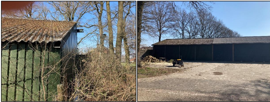
Figuur 2.5 (links): Impressie van de schuur, gezien vanaf de oostelijke zijde, met opgaande struikvegetatiestrook. Figuur 2.6 (rechts): Vooraanzicht van de schuur, gezien vanaf de noordwestelijke zijde.
