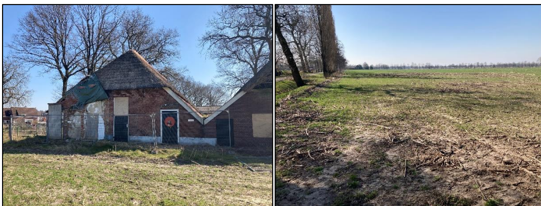
Figuur 2.11 (links): Impressie van de woning gezien van de noordwestelijke zijde. Opvallend is dat een deel van het dak de woning is ingestort; Figuur 2.12 (rechts): Impressie van het omliggende grasland.
