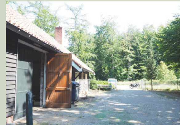
Zicht op bestaande schuur, toegang en verharding
