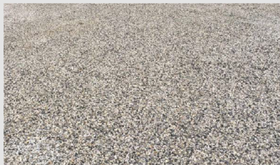
Halfverharding - grind op stabilisatieplaten
