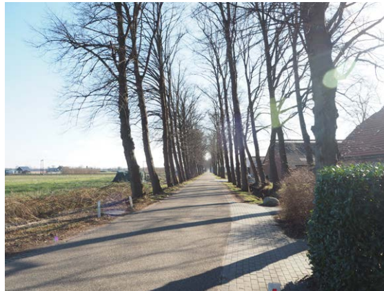
Bestaande dubbele rij lindes langs dijkweggetje
