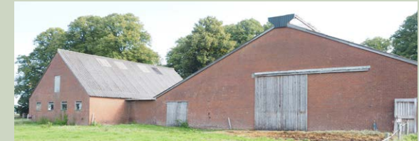
Zicht op te slopen schuren en kuilplaat
