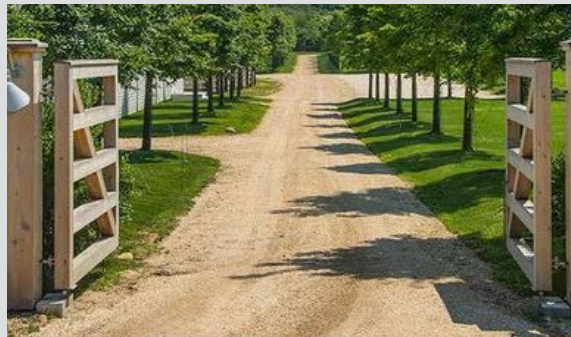
Aangestampt puin met deklaag van halfverharding
