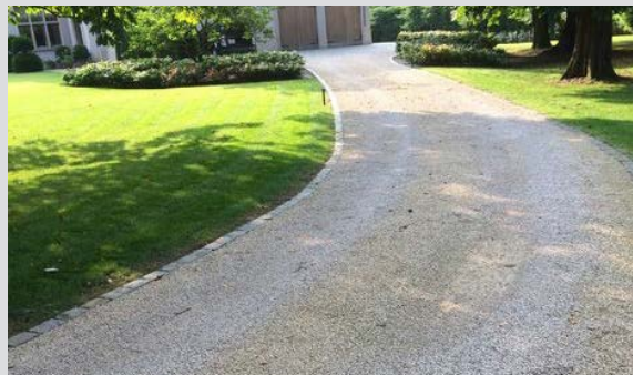
Aangestampt puin met laag van fijn grind
