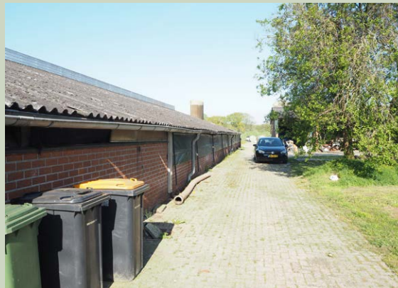
Zicht op veeststal, boomgroep en opslagschuur
