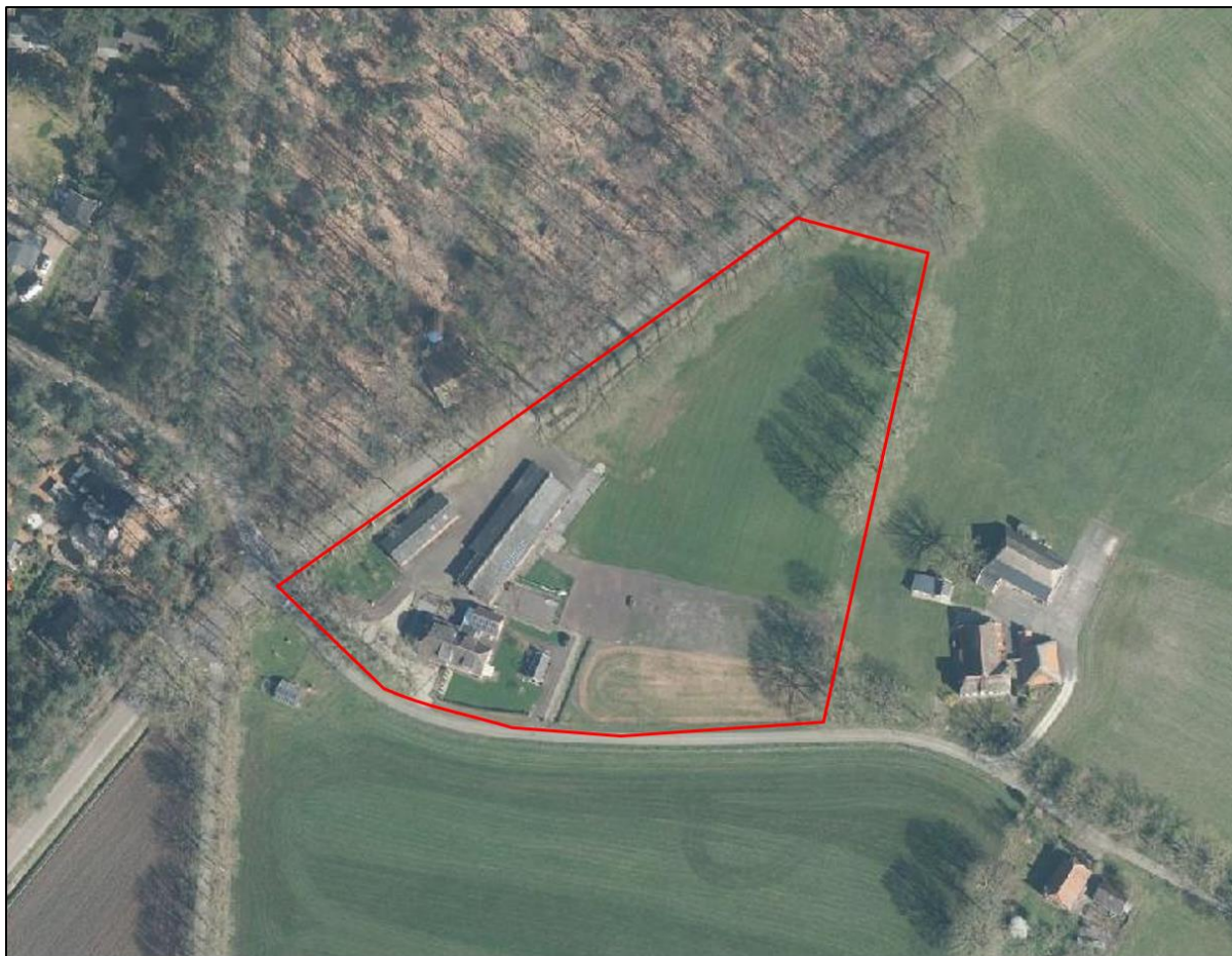
Afbeelding 2.1 Luchtfoto deelgebied Meutgeertsweg 2-2a (Bron: PDOK)
