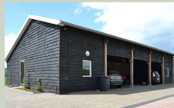
Schuur combinatie kapschuur/schuur
