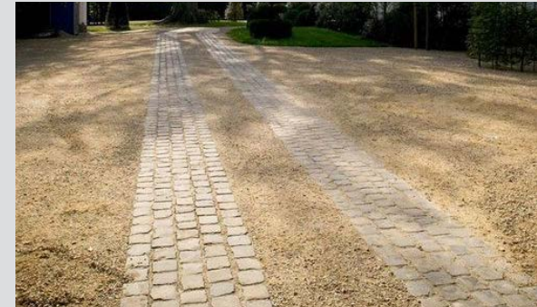
'Karrenspoor' van combinatie halfverharding en verharding
