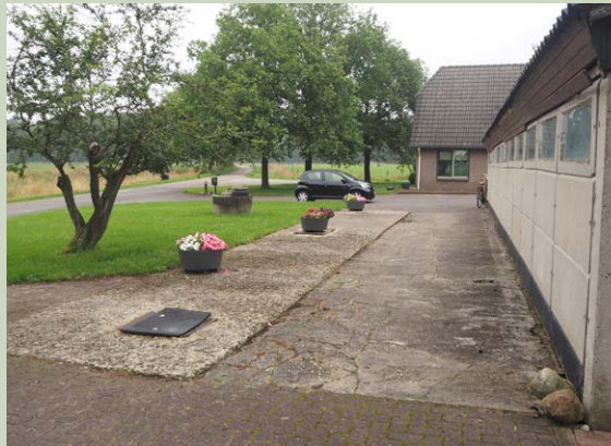
Bestaande boerderijwoning en open entree vanaf weg
