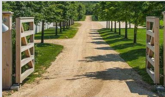
Aangestampt puin met deklaag van halfverharding
