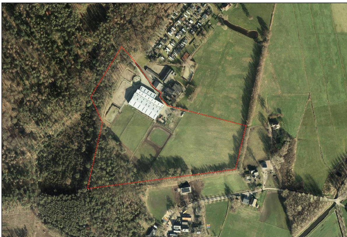
Afbeelding 2.1 Luchtfoto huidige situatie plangebied (Bron: Provincie Overijssel)
