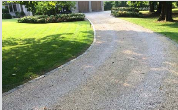
Aangestampt puin met laag van fijn grind
