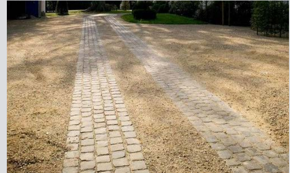
'Karrenspoor' van combinatie halfverharding en verharding
