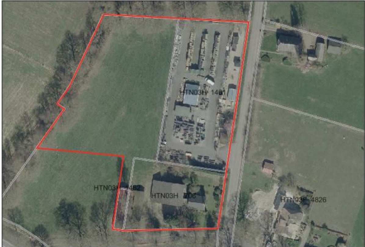
Afbeelding 2.1 Luchtfoto huidige situatie plangebied (Bron: Provincie Overijssel)
