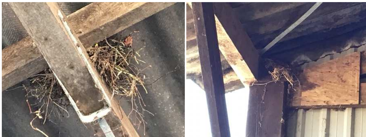
Aangetroffen oude vogelnesten in deelgebied Vonderschottenweg. Links een oud nest van de houtduif, rechts een oud nest van de merel.
