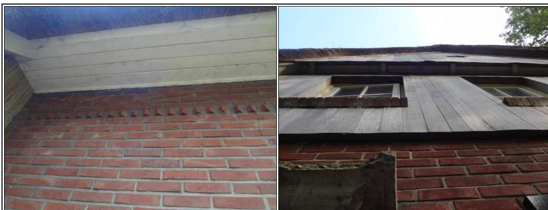
Afbeelding 4: Potentiële toegangsmogelijkheden voor vleermuizen in woning (foto's Aveco de Bondt, 2017).
