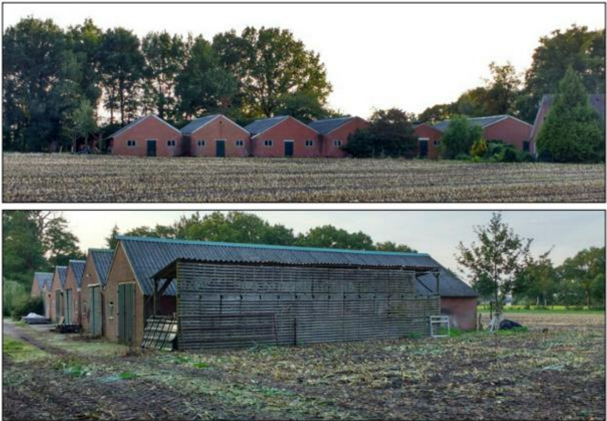
Figuur 2.2 Te slopen bebouwing (Bron: Initiatiefnemer)
