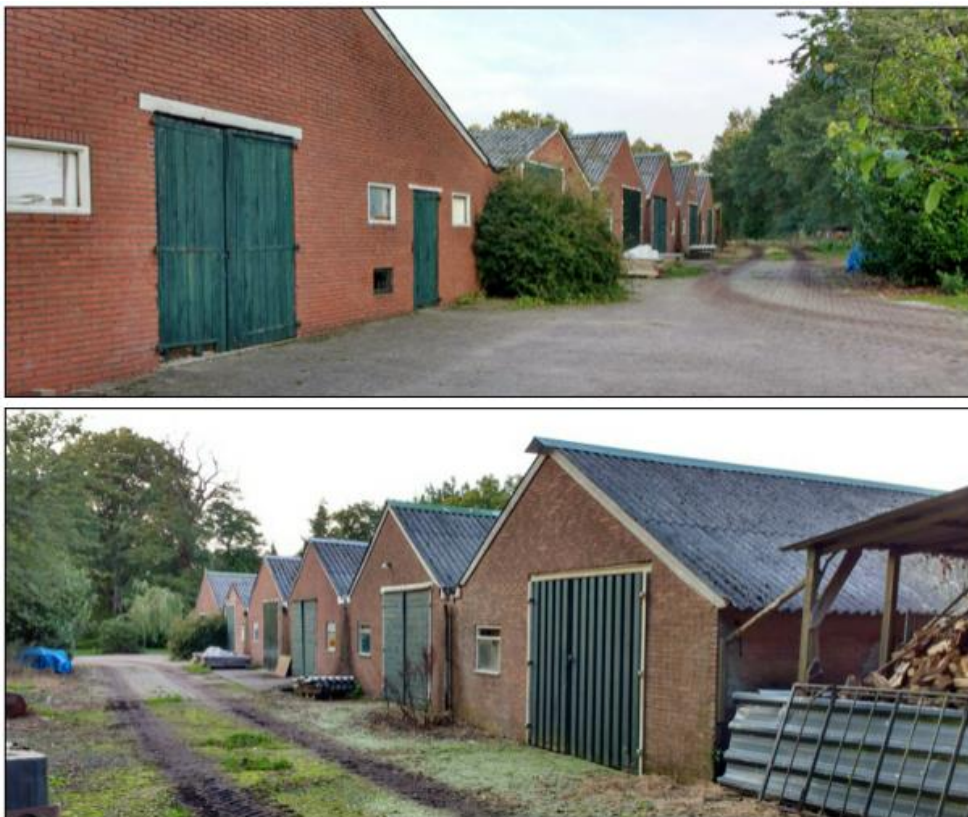
Figuur 2.3 Te slopen bebouwing (Bron: Initiatiefnemer)
