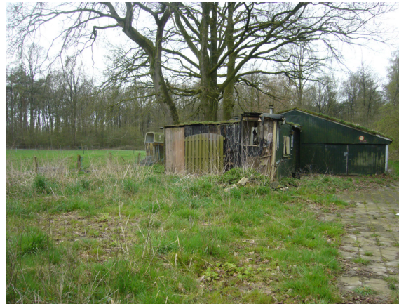
Afb. 1.2 Te verwijderen schuren aan entree perceel
