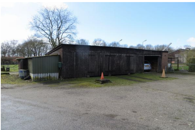
Figuur 7 te slopen bebouwing aan de Reebokkenweg
