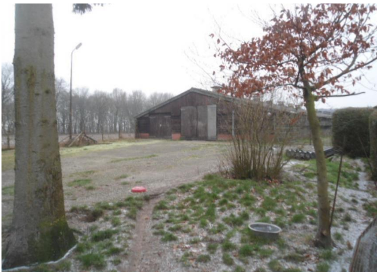
Figuur 6 Te slopen stal Reebokkenweg
