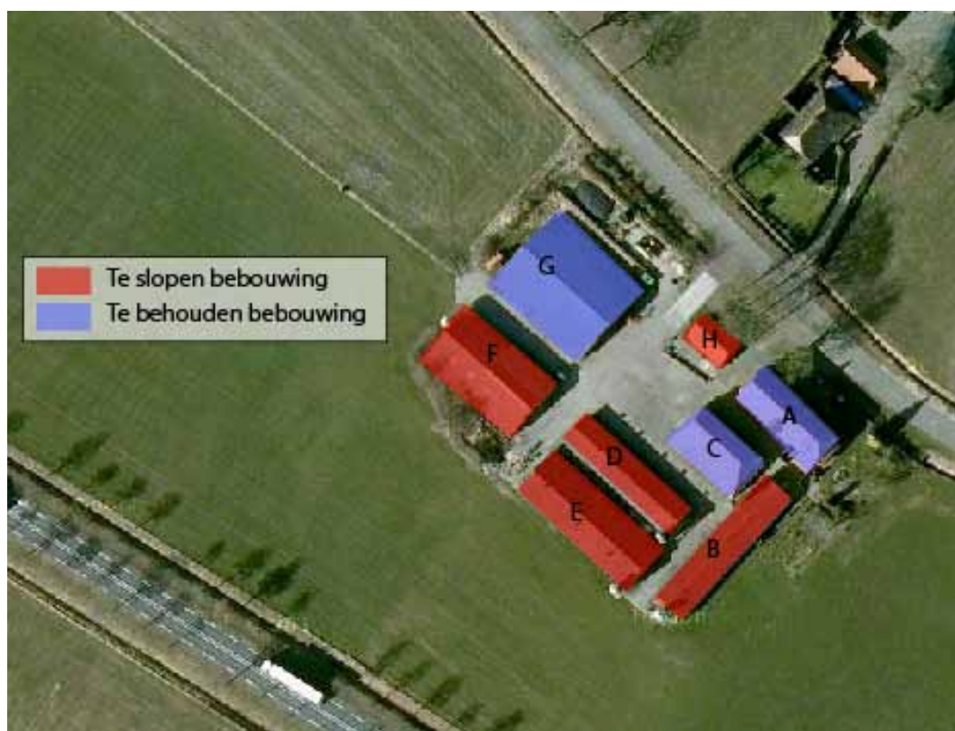
Afbeelding 10. Te slopen bebouwing Raalterweg
