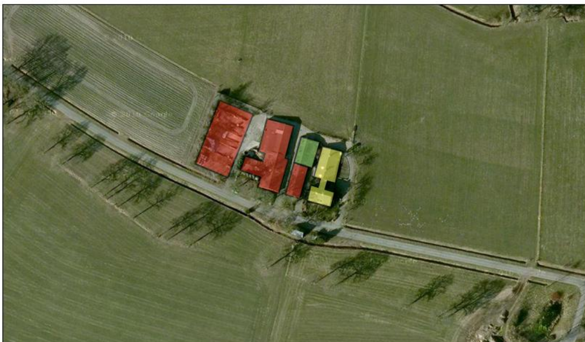
Afbeelding 3.1 Te slopen, te behouden en te vervangen bebouwing binnen het plangebied (Bron: Google maps)
