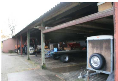
Te slopen bedrijfsopstallen
