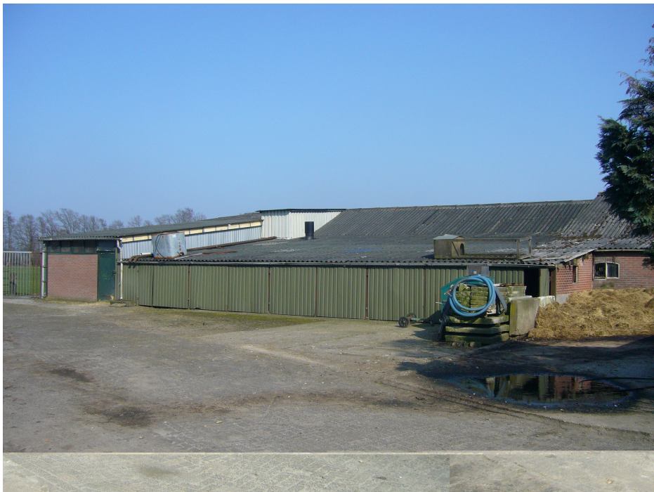
Foto 4: Gebouw D en E, zijaanzicht. Geheel te slopen
