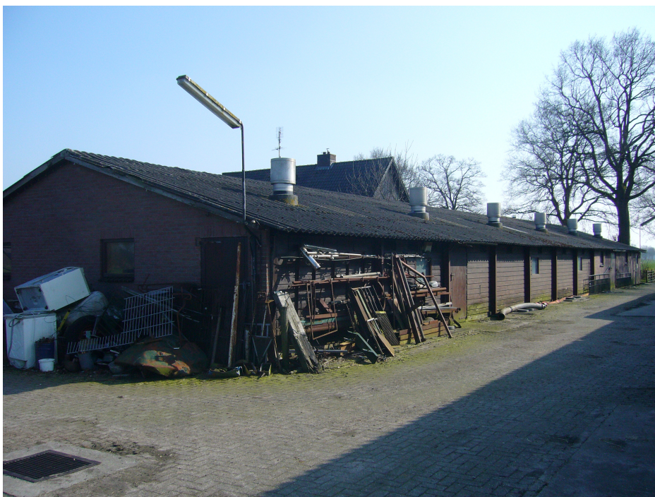
Foto 2: Gebouw C, geheel te slopen. Achterste deel herbouw
