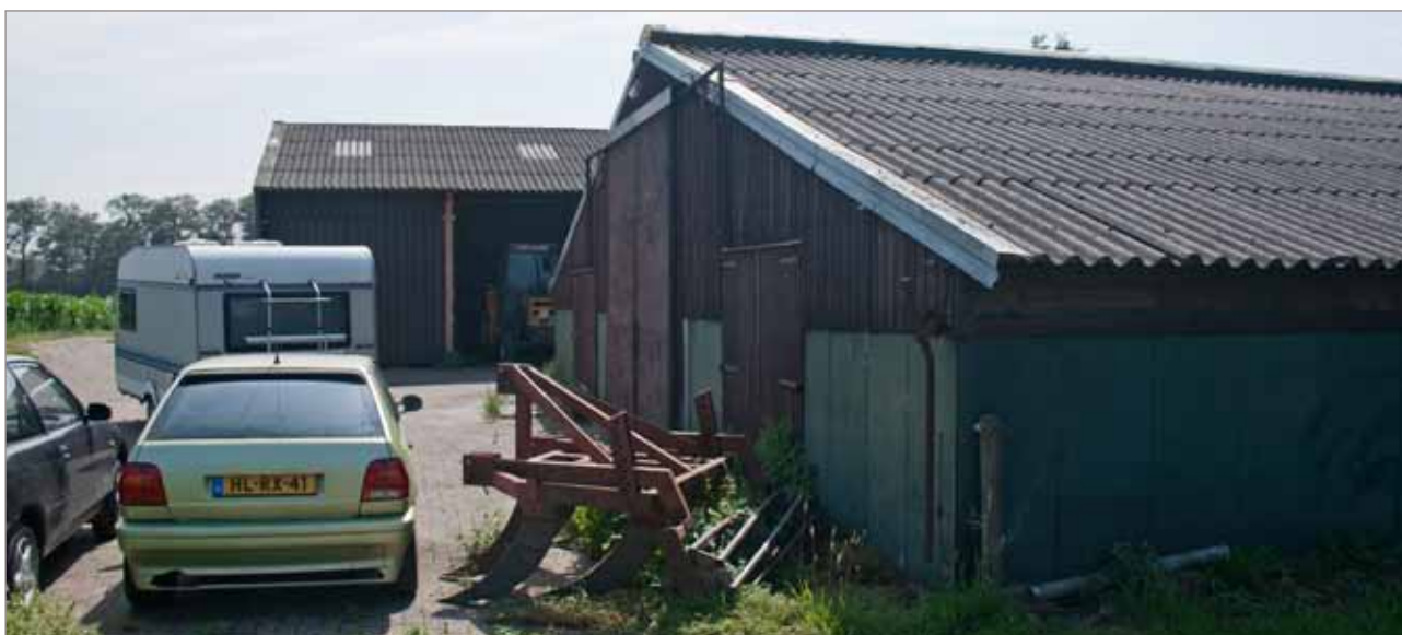
Afbeelding 3. Landschapsontsierende schuur en beplanting op bestaande erf
