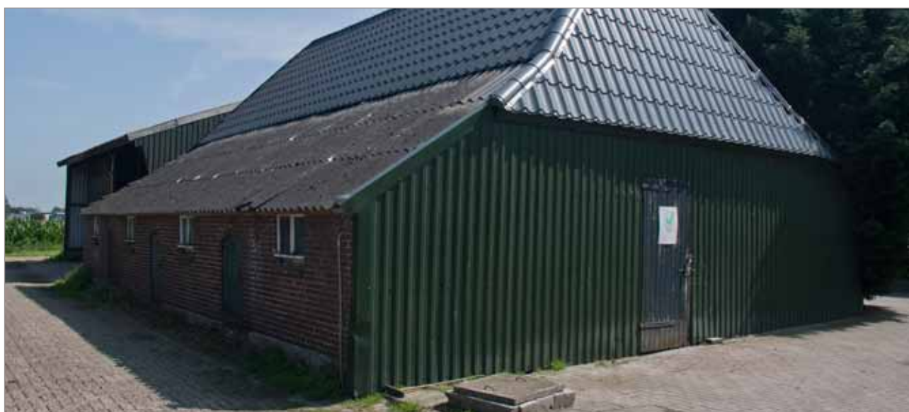
Afbeelding 7. Huidige situatie, te slopen schuur
