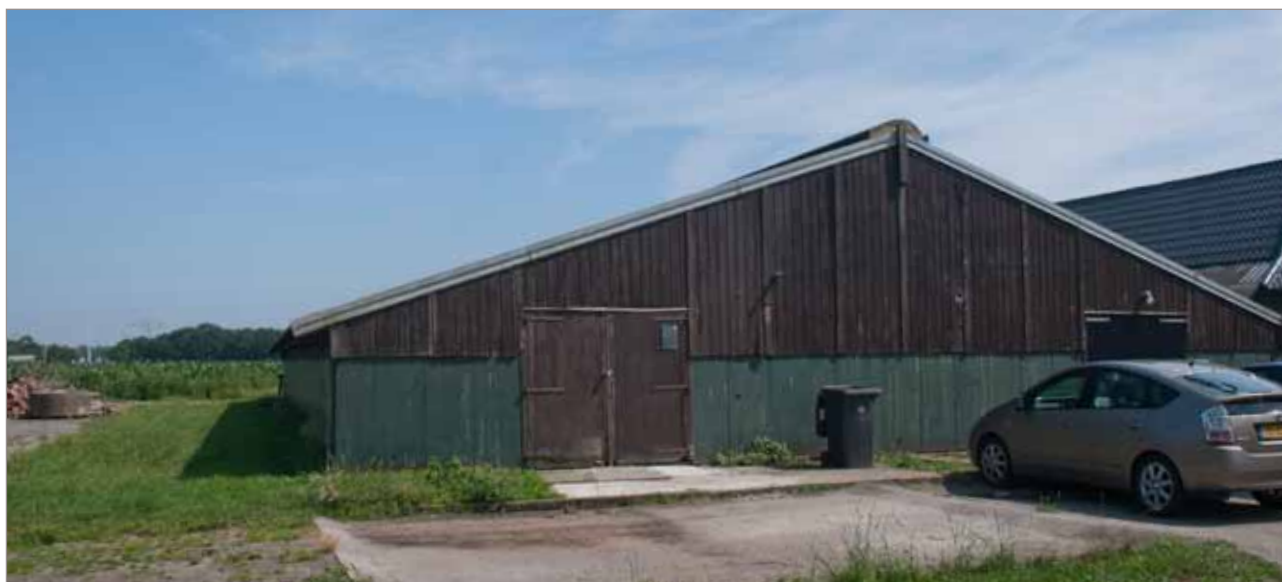
Afbeelding 4. Huidige situatie, te slopen schuur
