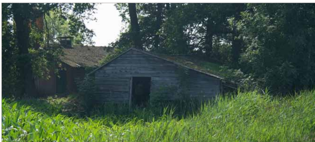
Afbeelding 6. Landschapsontsierende schuur en beplanting op bestaande erf
