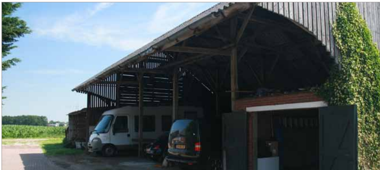
Afbeelding 5. Huidige situatie, te behouden voormalige graanschuur
