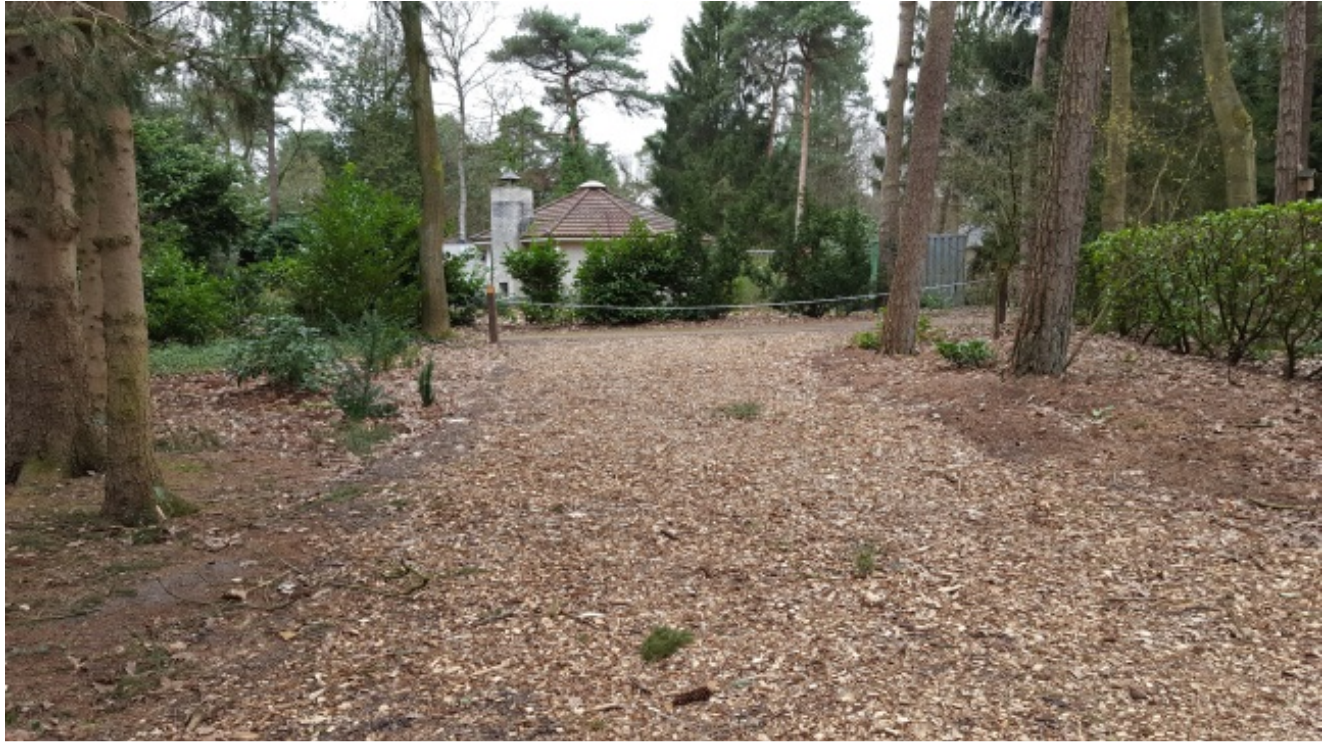
Gerealiseerde brandgang T: brandgang, afgesloten met een ketting aan 1 zijde. Verhard maar door houtsnippers weer een bosachtige uitstraling.
