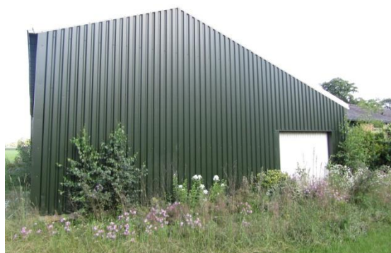
Afbeelding 1 de te verplaatsen kapschuur.
