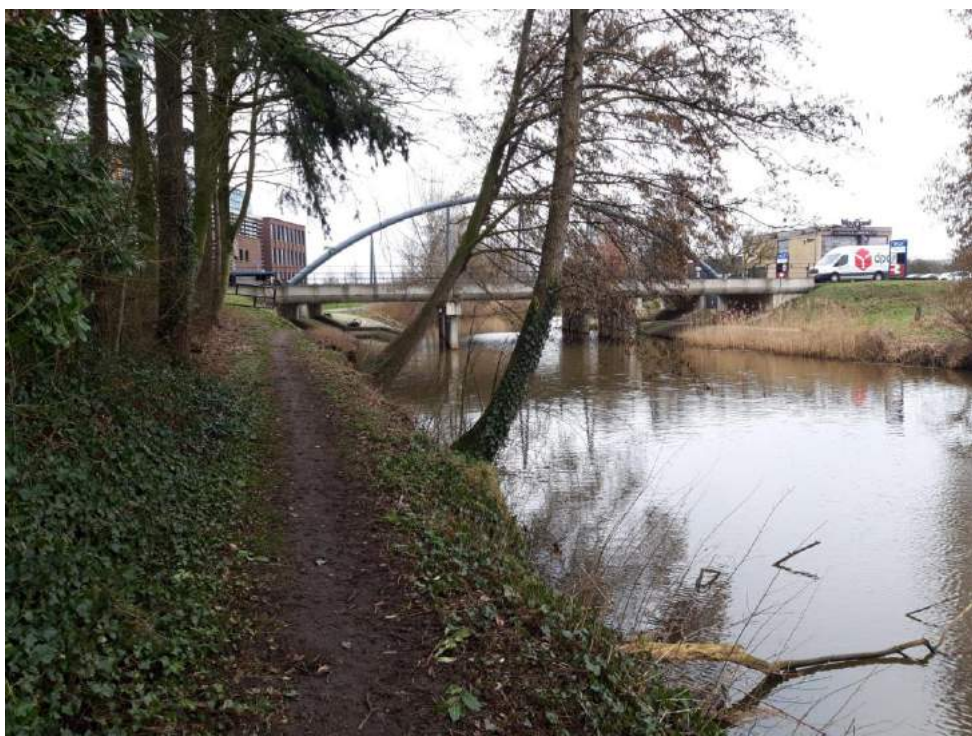
foto 6: Brug over de N350
