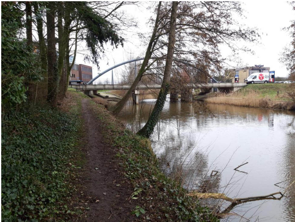
foto 6: Brug over de N350
