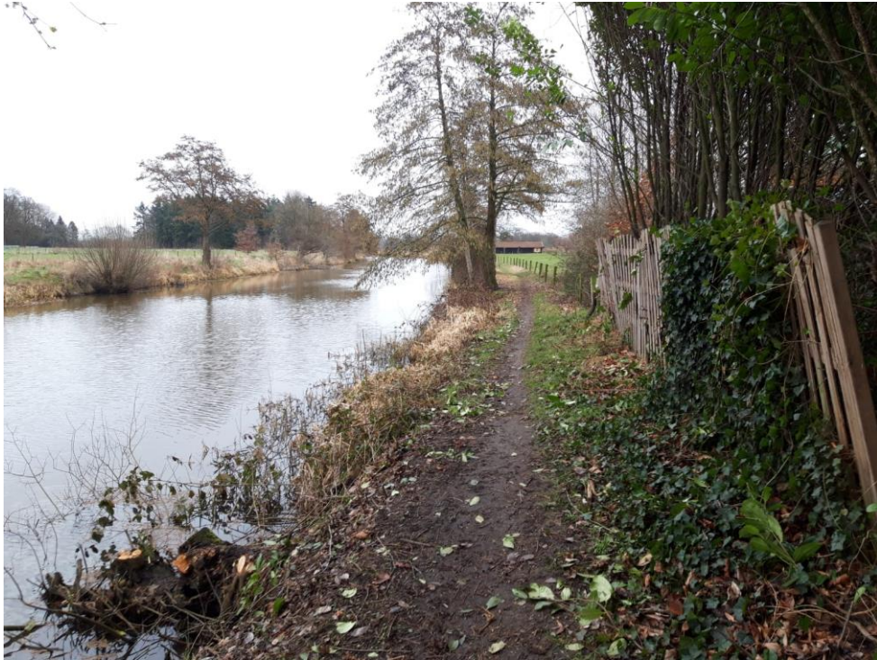
foto 5: Watergang met schuttingen ter plaatse van de brug over de N350
