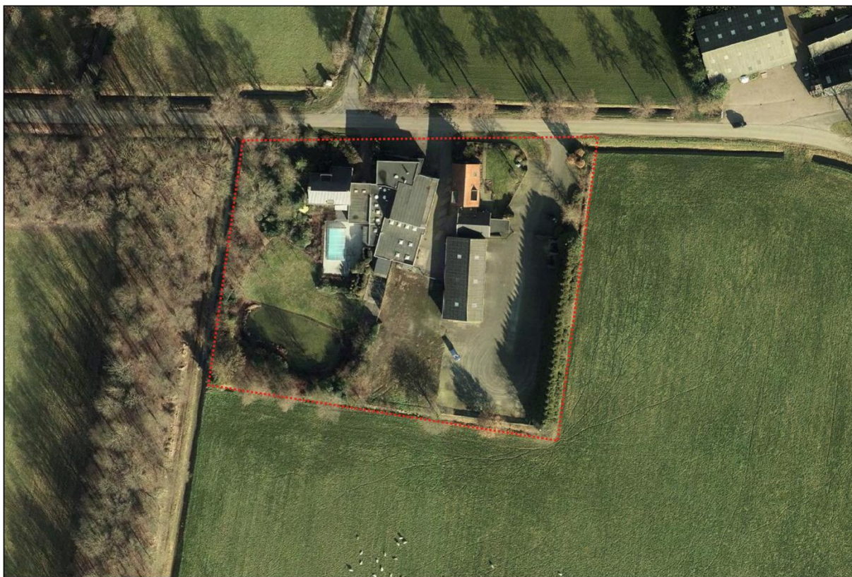
Afbeelding 2.1 Luchtfoto huidige situatie plangebied (Bron: Provincie Overijssel)
