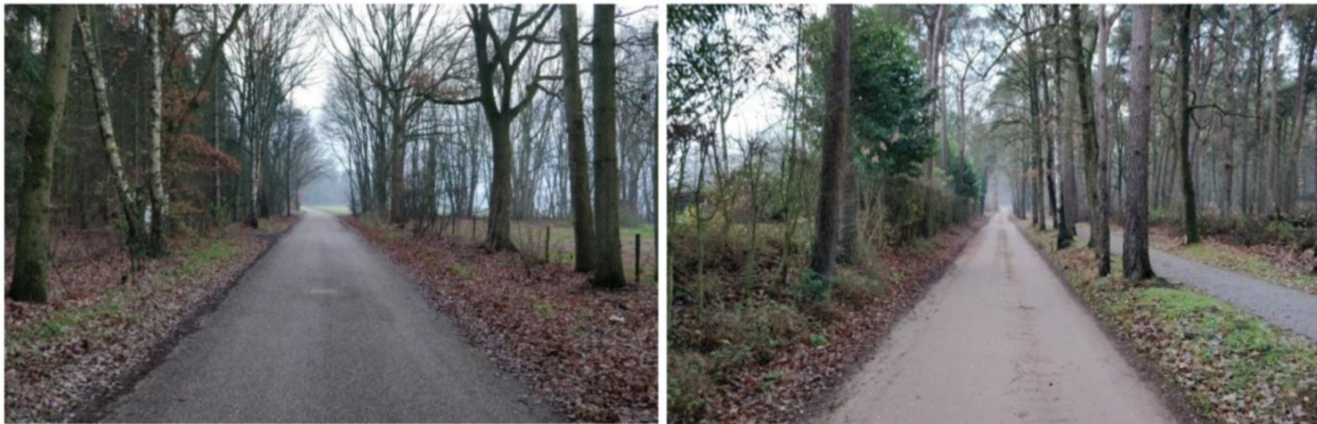
Figuur 3.2 Reebokkenweg (links) en Forthaarsweg (rechts)
