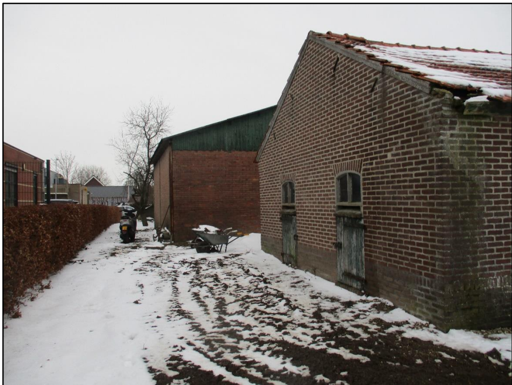
Figuur 6 De noordzijde van de planlocatie, kijkend richting het oosten.
